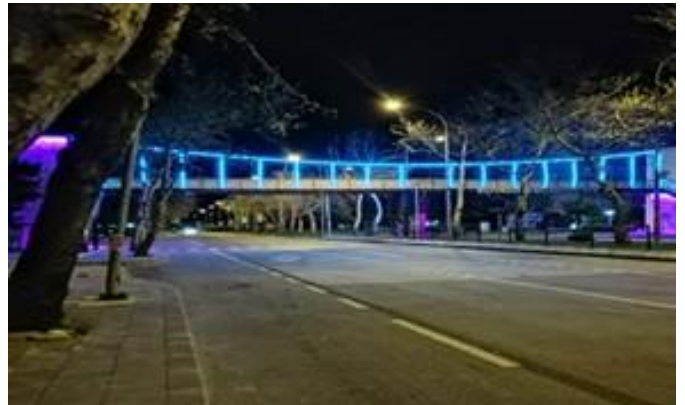
12 Şubat İlçesinde bulunan üstgeçit mavi ışıkla aydınlatıldı
